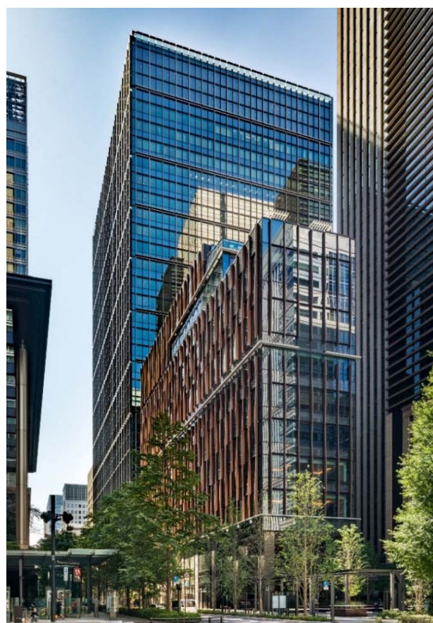
永代通り側から望む「丸の内テラス」
