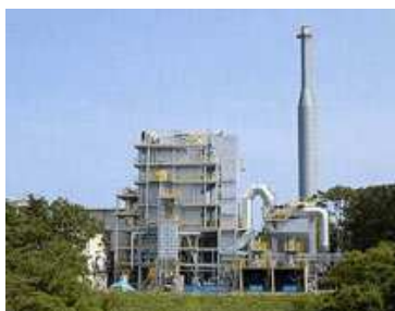
木質バイオマス発電所
