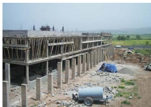
イラクのハラブジャ病院建設現場 ©ピースウィンズ・ジャパン
