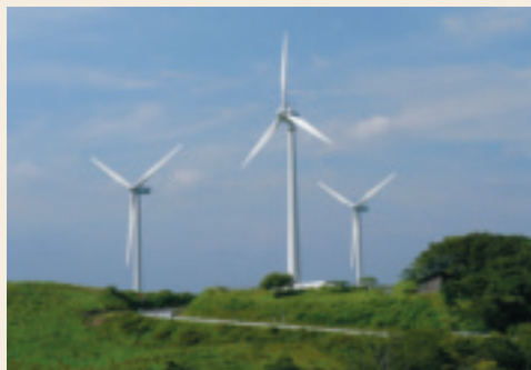
里美牧場風力発電所(茨城県常陸太田市)
