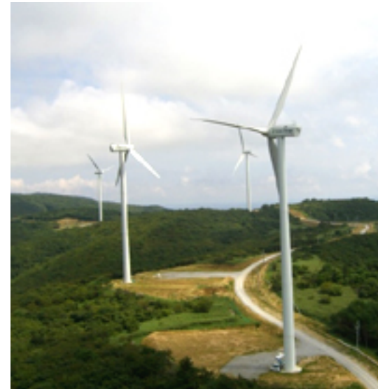
再生可能エネルギー事業(風力発電)への融資
