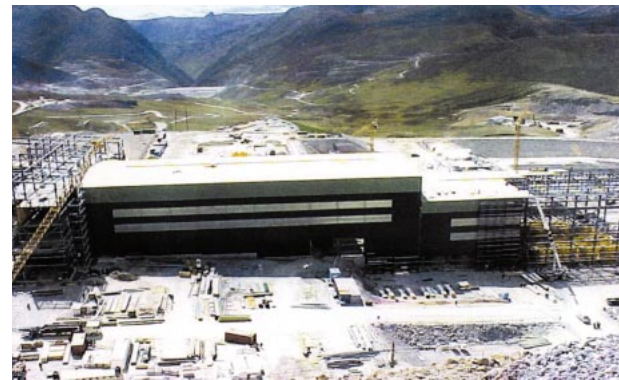
ペルー銅山開発案件建設風景
